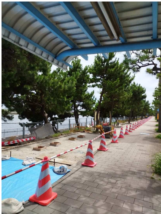
つばさ公園バス停前の拡幅工事
